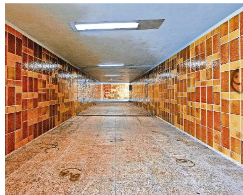
Entgegen der Befürchtung vieler Eltern ist die Unterführung im Inneren ausgeleuchtet und sauber. Lediglich Graffiti „ziert“ die Wände und den Boden des Altbaus.
