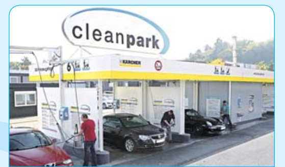
Die gepflegte Anlage bietet eine Vielzahl an Reinigungsmöglichkeiten.
